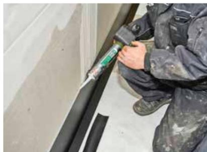
▲ Sicher gegen Hinterläufigkeit: Obere Versiegelung des Edelstahlverbundprofils mit Silikon
