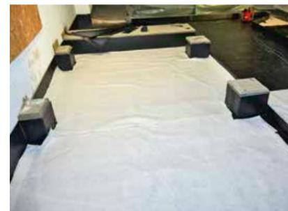
▲ Als Schutzlage haben die Dachdecker auf der Kunststoffabdichtung ein Vlies verlegt
